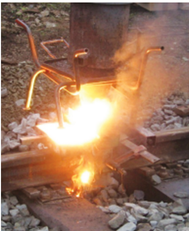
Slika 7.4. Spajanje tračnica alumotermijskim varenjem
