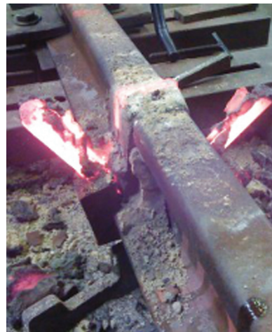
Slika 7.4. Spajanje tračnica alumotermijskim varenjem
