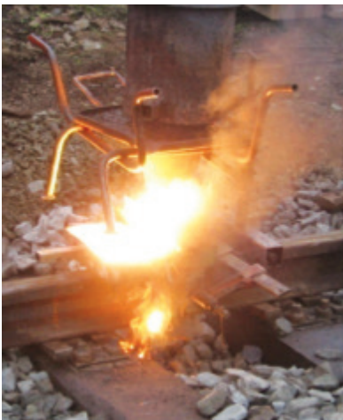
Slika 7.4. Spajanje tračnica alumotermijskim varenjem
