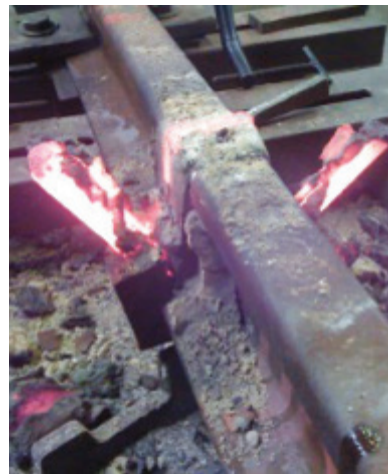
Slika 7.4. Spajanje tračnica alumotermijskim varenjem
