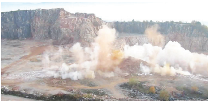
Slika 7.27. Miniranje tla s ciljem probijanja saobraćajnica; Znak za opasnost – eksplozivna tvar
